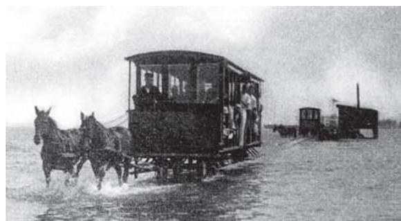
Pferdebetrieb auf der Inselbahn Langeoog. Im Hintergrund: der Anleger. Die Gleise lagen ohne Unterbau auf dem Sandboden im Watt.
