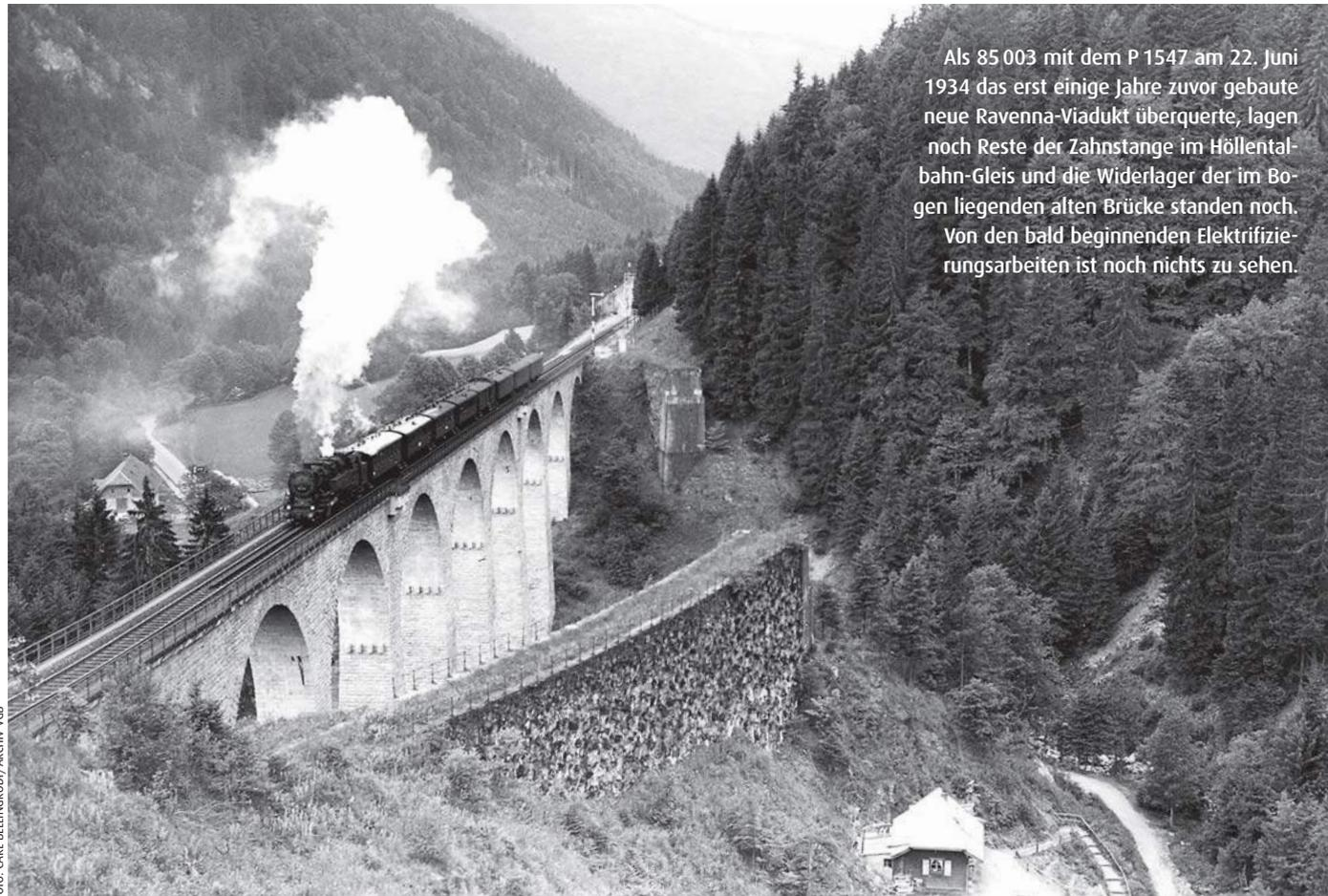
Als 85 003 mit dem P 1547 am 22. Juni 1934 das erst einige Jahre zuvor gebaute neue Ravenna-Viadukt überquerte, lagen noch Reste der Zahnstange im Höllentalbahn-Gleis und die Widerlager der im Bogen liegenden alten Brücke standen noch. Von den bald beginnenden Elektrifizierungsarbeiten ist noch nichts zu sehen.
