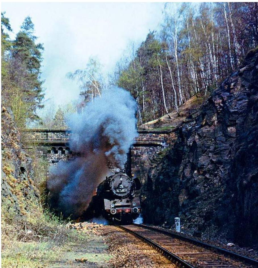
Die südliche Ausfahrt aus dem Waldheimer Pfaffenbergtunnel. Man erkennt links die Lage des 1945 angebauten zweiten Streckengleises. 503583 dampft weiter in Richtung Mittweida.
