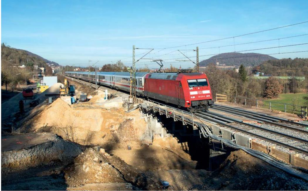
Die provisorische Brücke nahe Treuchtlingen ist errichtet. Jetzt wird von unten bei laufendem Betrieb eine neue Brücke eingebaut.
