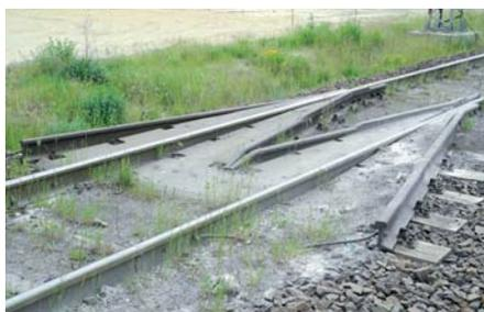
Stationäre Eingleiser am Ende eines Strossengleises in der Deponie II.
