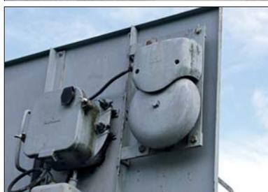
Nur das in Fahrtrichtung jeweils rechte Signal verfügt über ein Lätzewerk. Das Gussteil dafür wird auf zwei Haltestiften des Rahmens verlötet.
