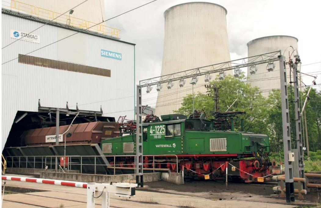
Kohleverladeanlage im Kraftwerk Boxberg: Rohbraunkohle aus dem Tagebau Reichwalde oder Nochten wird von hier zu den Kraftwerken Schwarze Pumpe oder Jänschwalde gefahren.
