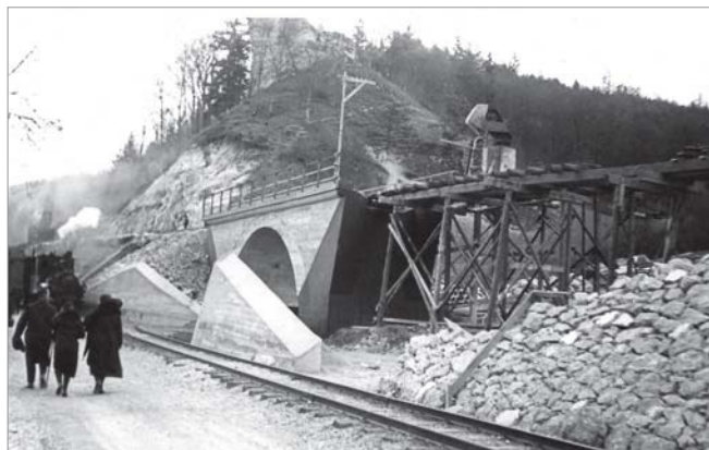
Um 1933 ist der Bau der neuen Normalspurtrasse bei Wasserzell in vollem Gange. Im Vordergrund liegt die alte Schmalspurstrecke.
