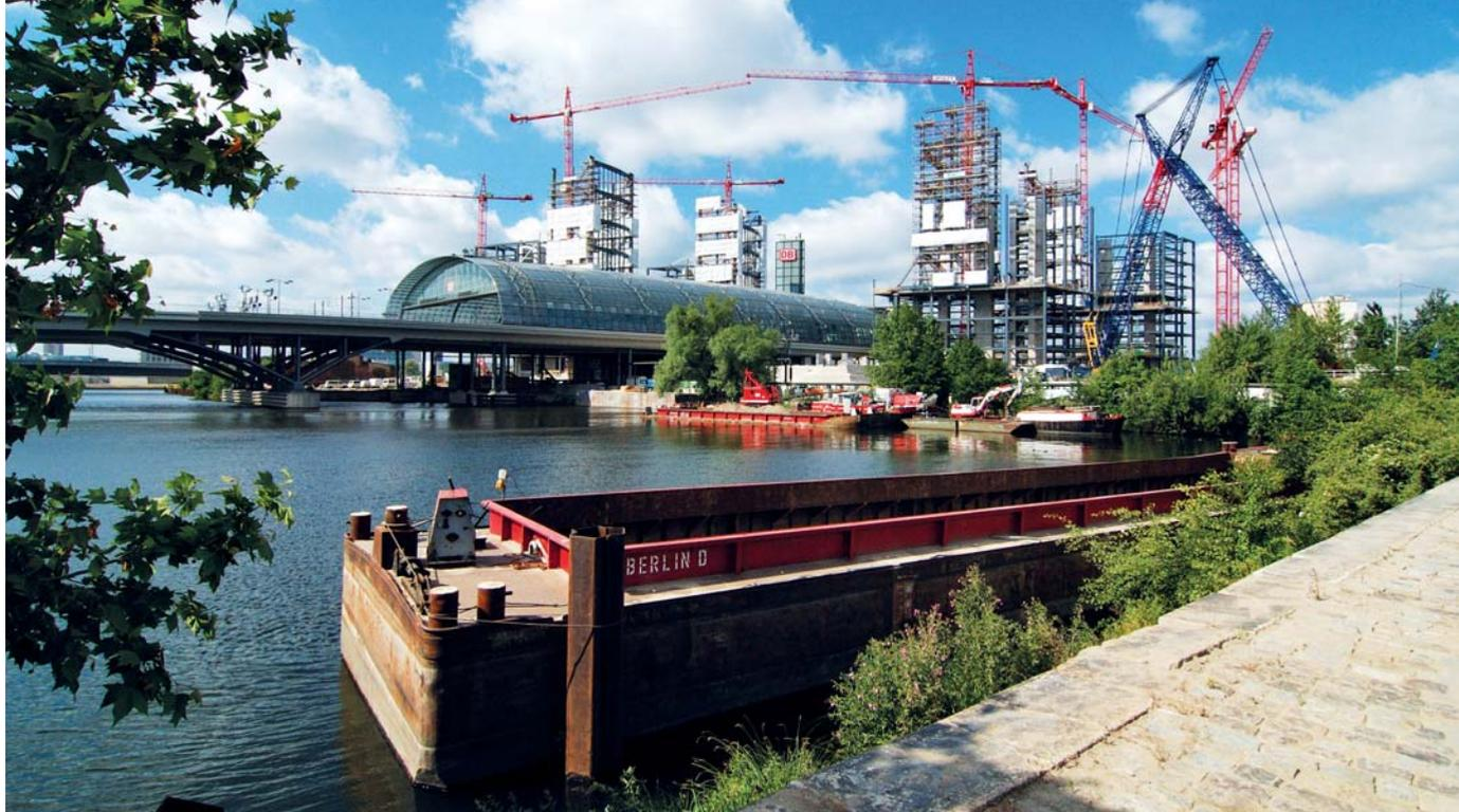
Zweimal 2500 Tonnen Stahl für die beiden Bügel werden vor dem Kippen senkrecht gen Himmel aufgebaut. Im Vordergrund befindet sich der Humboldt-Hafen. Die Aufnahme entstand am 28. Juni 2005.
