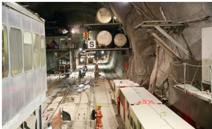
Die Bahn für die Bahn: Während des Baus der Tunnelröhren entstand ein ausgedehntes Grubenbahnsystem für den Gütertransport.
