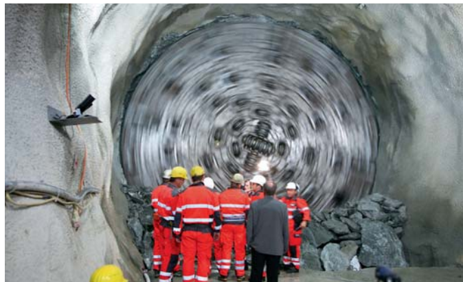
Einer der diversen Durchbrüche, die gefeiert wurden: Eine Tunnelbohrmaschine hat sich soeben durch das letzte Gestein gefräst.
