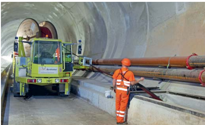
Die Tunnel-Infrastruktur ist mehr als beeindruckend. Kilometerlange Kabel zur Stromversorgung und für die Signalisierung wurden verlegt.
