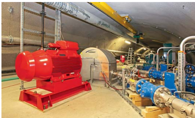
Zur Infrastruktur gehören ein gigantisches Belüftungs-, aber auch ein umfangreiches Löschwassersystem (Bild).
