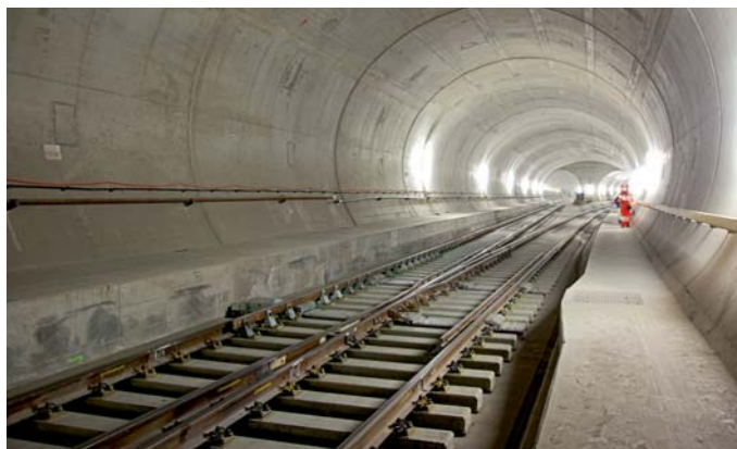
An den beiden Rettungs- und Multifunktionsstellen Faido und Sedrun liegen Schnellfahrweichen für den Gleiswechsel.
