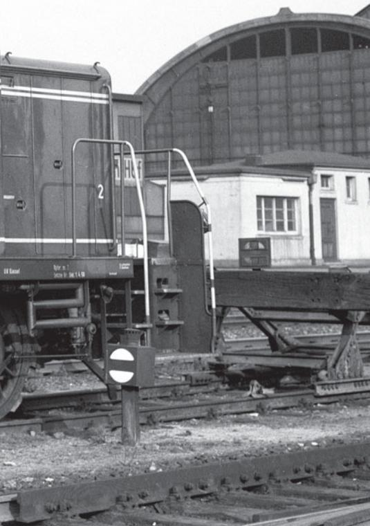
Gut zu sehen sind die Schlauchverbindungen zur Doppeltraktionssteuerung an der Stirnseite der V60 1019, die neben einer zweiten V60 als Prototyp für diese Steuerung diente.
