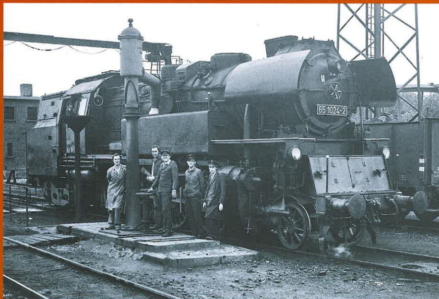
Am Ende der DMV-Sonderfahrt des BV Halle am 27. Mai 1978 versammeln sich einige Enthusiasten im Bw Altenburg um die 65 1024, deren Giesl-Ejektor gut zu erkennen ist.
