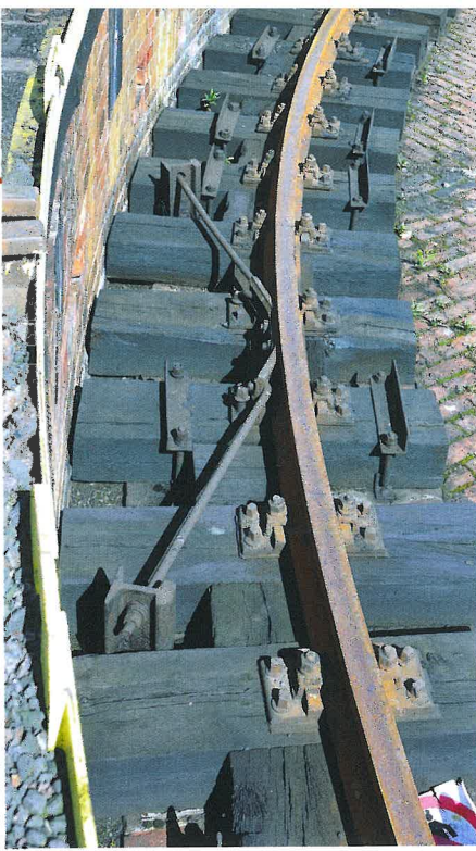
Einer der vier Anker des Laufkreises. Die Eisenwinkel dienen zur Sicherung der unbefestigten Schwellen. 40 Stück sind verbaut.
