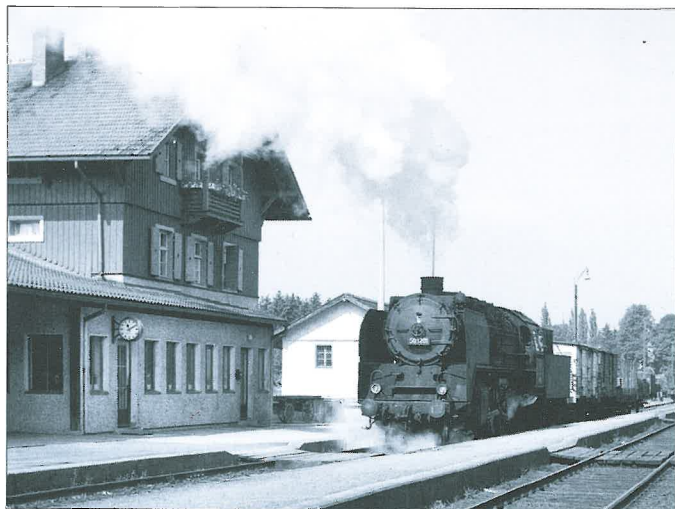
In den 50er-Jahren rangiert 50 1201 im Bahnhof Dießen. Inzwischen ist das Gleisbild bis auf zwei Gleise radikal zurückgebaut worden.
