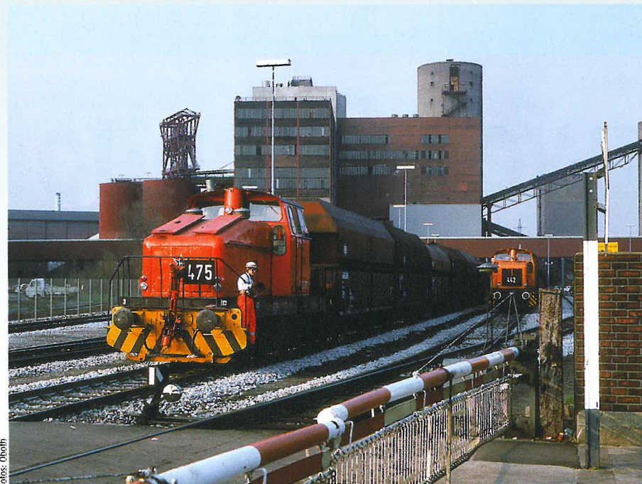
Bei einer täglichen Förderleistung von 10000 t verwertbarer Kohle waren derartig viele Rangierfahrten notwendig, dass die Schranken weitaus häufiger geschlossen als geöffnet waren.
