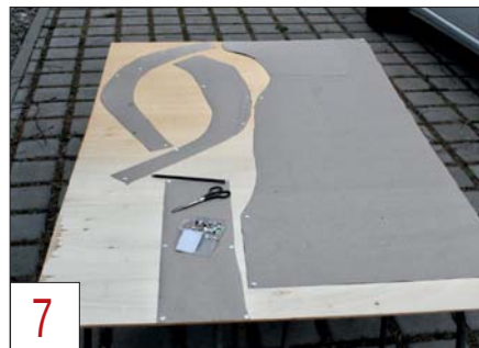
7 Zuschneiden der Trassenbretter draußen auf dem Stellplatz. Als Vorlage dienen ausgeschnittene Kartonstücke.
