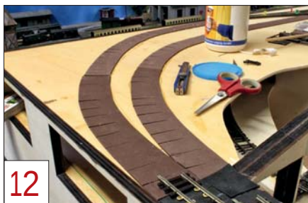
12 Im sichtbaren Bereich erhielten die Gleise eine Unterlage aus Moosgummi, um das Schotterbett nachbilden zu können.
