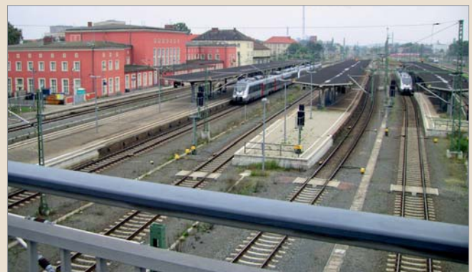
Das Foto aus dem Jahr 2016 zeigt das sanierte Empfangsgebäude und die umgestalteten und vereinfachten Gleisstrukturen.
