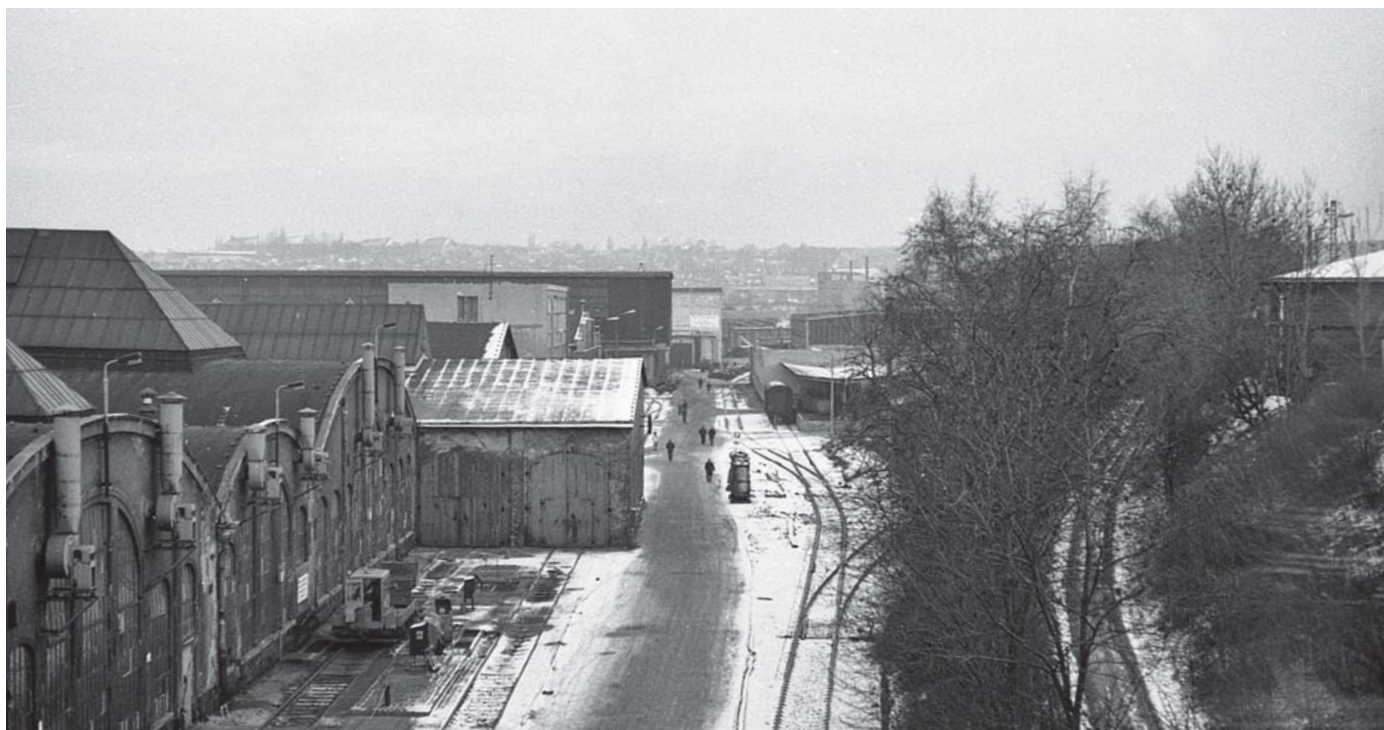
Blick aus der Lok vom Verbindungsbogen RC-Linie (Riesa-Chemnitz-Linie) – Chemnitz-Hilbersdorf aus auf die Hallen und das „Mauergleis“.
