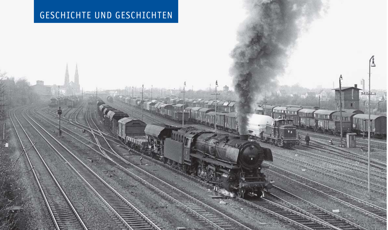
Hochbetrieb im Rangierbahnhof Soest Ostern 1967: Im Vordergrund macht sich die damals noch in Paderborn beheimatete 44 403 mit einem langen Güterzug auf den Weg in Richtung Eggegebirge; dahinter drückt V60 441 vom Bw Hamm einen Zug auf.
