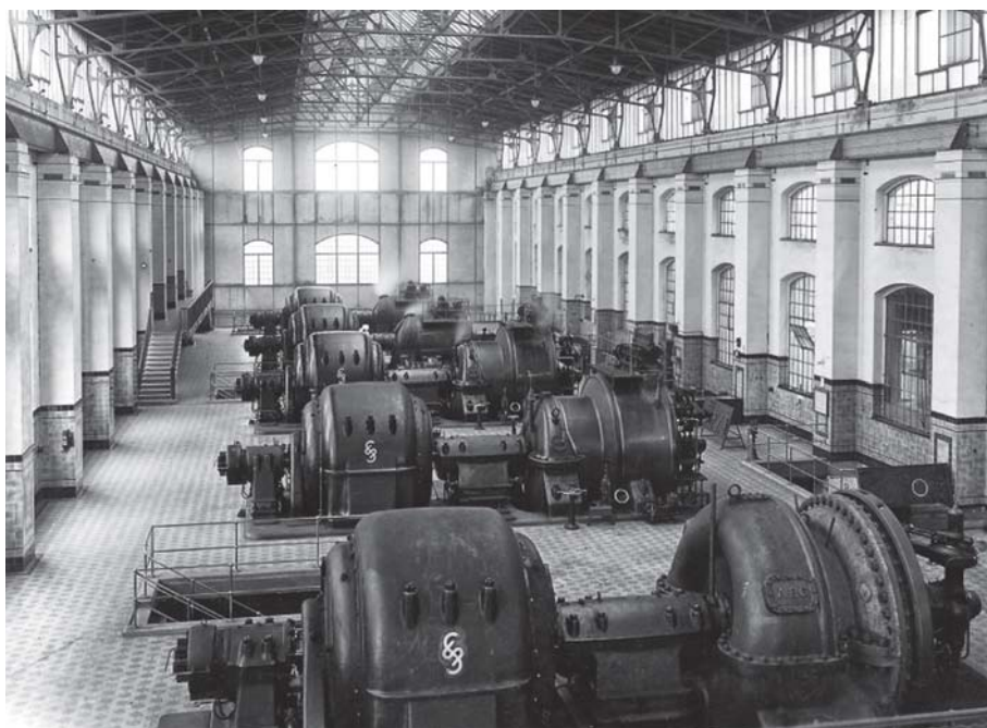
Blick in das Maschinenhaus des Rkw Muldenstein mit den fünf 3,3-MW-Bahnstrommaschinen von Siemens und Halske.
