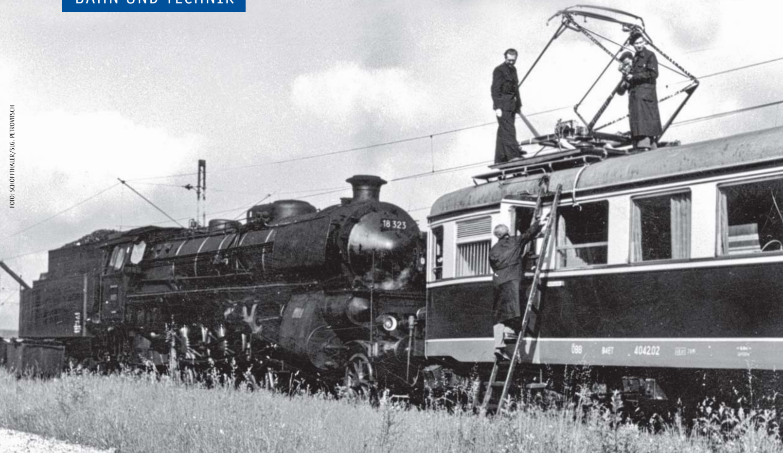
Stromabnehmer-Vergleichstest UIC/ORE: Ausrüstungsarbeiten an einem Mess-Stromabnehmer auf dem (zu diesem Zweck demotorisierten) ET 4042.02 der ÖBB vor Schublok 18 323 (ehemalige bad. IVh) der DB-Versuchsanstalt Minden in der Zugförderung Wörgl im Mai 1956.
