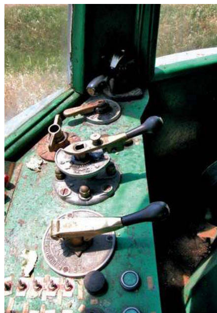
Archaisch wirkend, aber noch funktionsfähig: Bedienelemente im Führerstand des 42001.
