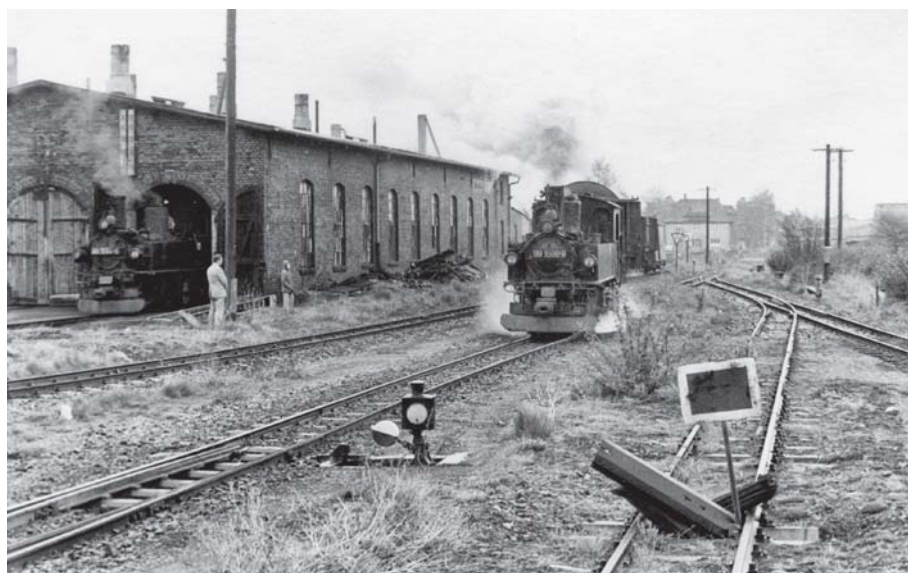
Als provisorischen Gleisabschluss legte beziehungsweise steckte man oft auch alte Schwellen ins Gleis und ergänzte das Ganze durch eine Sh2-Tafel (Mügeln, 6. Mai 1979).
