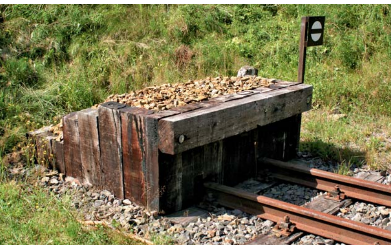
Unter anderem in Oybin ist ein solcher aus u-förmig angeordneten Altschwellen bestehender Prellbock zu finden.
