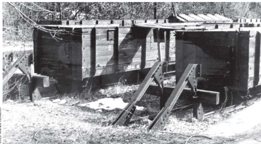
Im Bahnhof Rabenau waren 1973 zwei Abstellgleise mit Prellböcken ausgestattet, die aus verschraubten Schienenprofilen bestanden. Heute befinden sich beide in Freital-Hainsberg.
