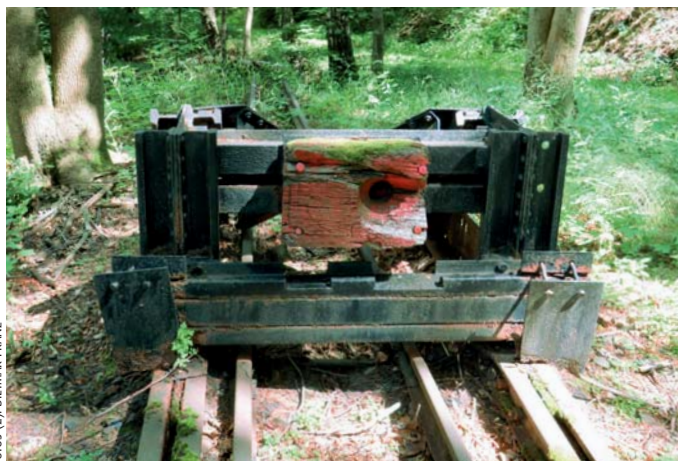
Aus Schienenprofilen besteht dieser Prellbock am Ende des nördlichen Ausziehgleises des Bahnhofs Kurort Kipsdorf.
