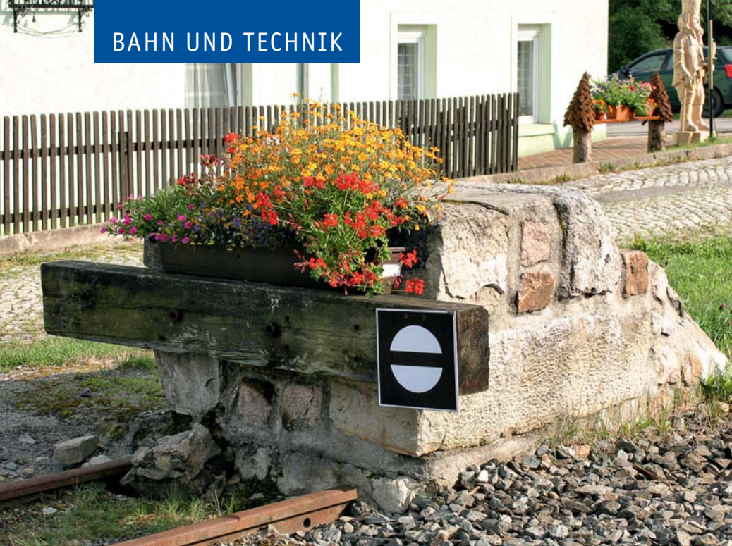
Gemauerte, hinten abfallende Prellböcke waren im Bereich der Bahnmeisterei Annaberg-Buchholz häufiger anzutreffen. In Hammerunterwiesenthal steht dieses geschmückte Exemplar.
