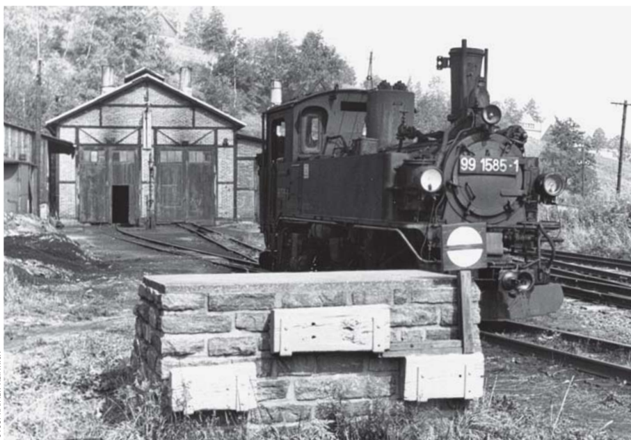
Ein Prellbock aus sieben Bruchstein-Schichten, mit drei Anstoßflächen versehen, markierte in Jöhstadt des Ende des Güterschuppengleises. Das Foto stammt vom 12. September 1979.
