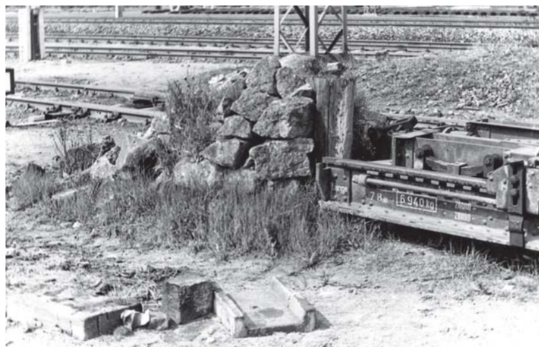
Ein Werkstattgleis im Bahnhof Oschatz endete 1979 an dieser primitiven Prellbock-Bauform, gebildet aus einer Schwelle und Bruchsteinen.
