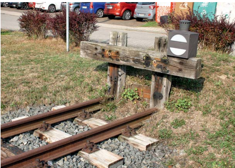
In Glossen endet der 2006 wieder aufgebaute Abschnitt der Döllnitzbahn von Nebitzschen an einem Prellbock aus Holzschwellen.
