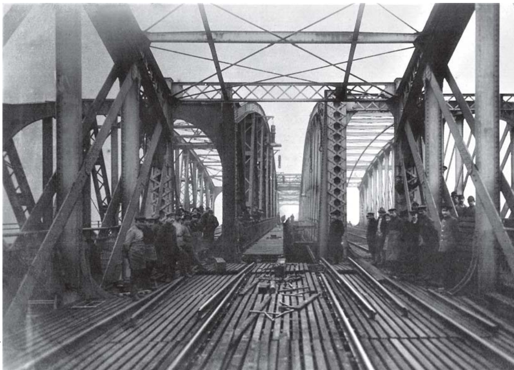
1908 und 1909 wurden die alten schmiedeeisernen Überbauten der Brücke durch solche aus Stahl ersetzt. Das Foto zeigt den Tausch des Stromüberbaus II während der Verschiebung.
