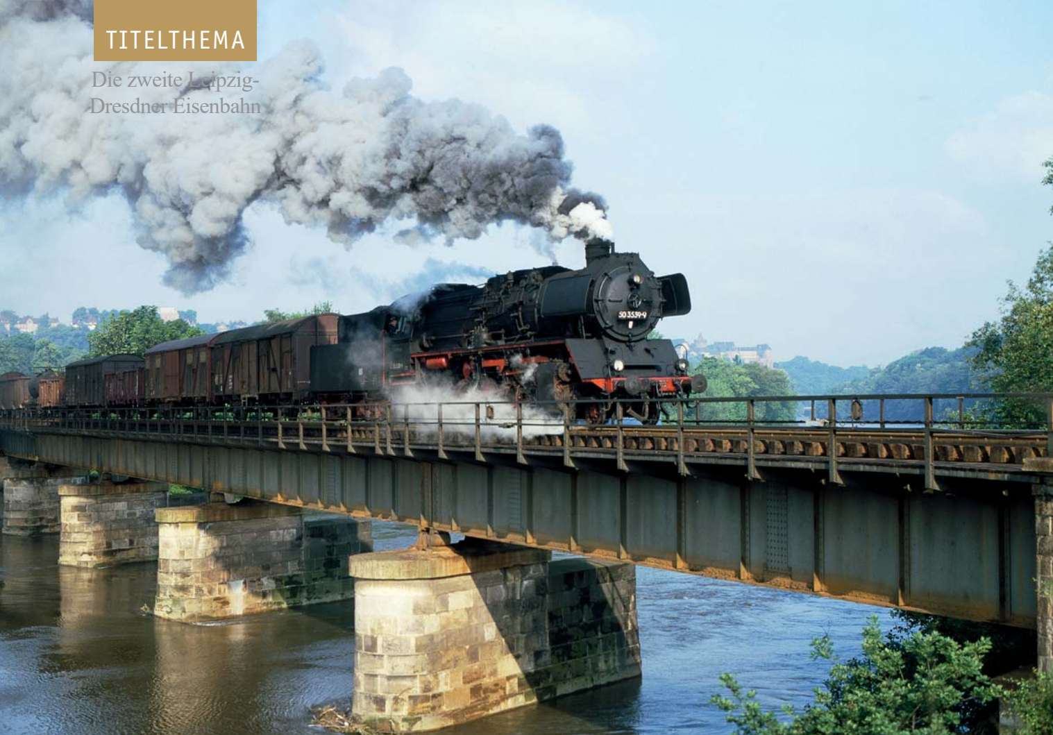
Noch gut zu tun hat 50 3539 am 4. Juni 1986 auf der Muldebrücke bei Leisnig mit dem Ng62323 von Großbothen nach Döbeln.
