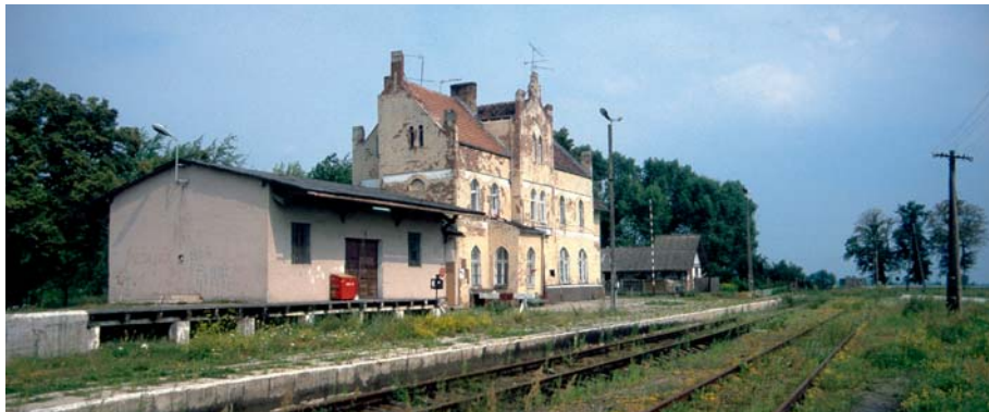
Der ehemalige Bahnhof von Gniew, dem früheren Mewe. Hier bewegt sich nichts mehr. Die Strecke Morzeszczyn – Gniew (Morroschin/Leutmannsdorf – Mewe) wurde 1992 stillgelegt.
