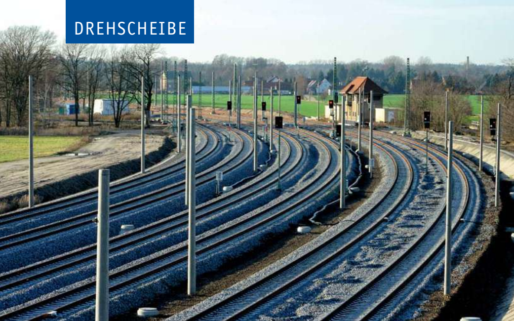
Horka Gbf am 20. Dezember 2015: Bis zu 740 Meter lange Güterzüge werden künftig ohne technische Hindernisse grenzüberschreitend über diese Strecke rollen, ab 2021 auch unter Nutzung des europäischen Zugsicherungssystems ETCS.
