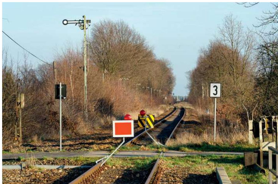
Kein Durchkommen mehr: Im Dezember 2015 zeigte sich der Abzweig Särichen mit dem Gleis vom/zum Gbf in Horka mit Sh2-Scheiben versehen.
