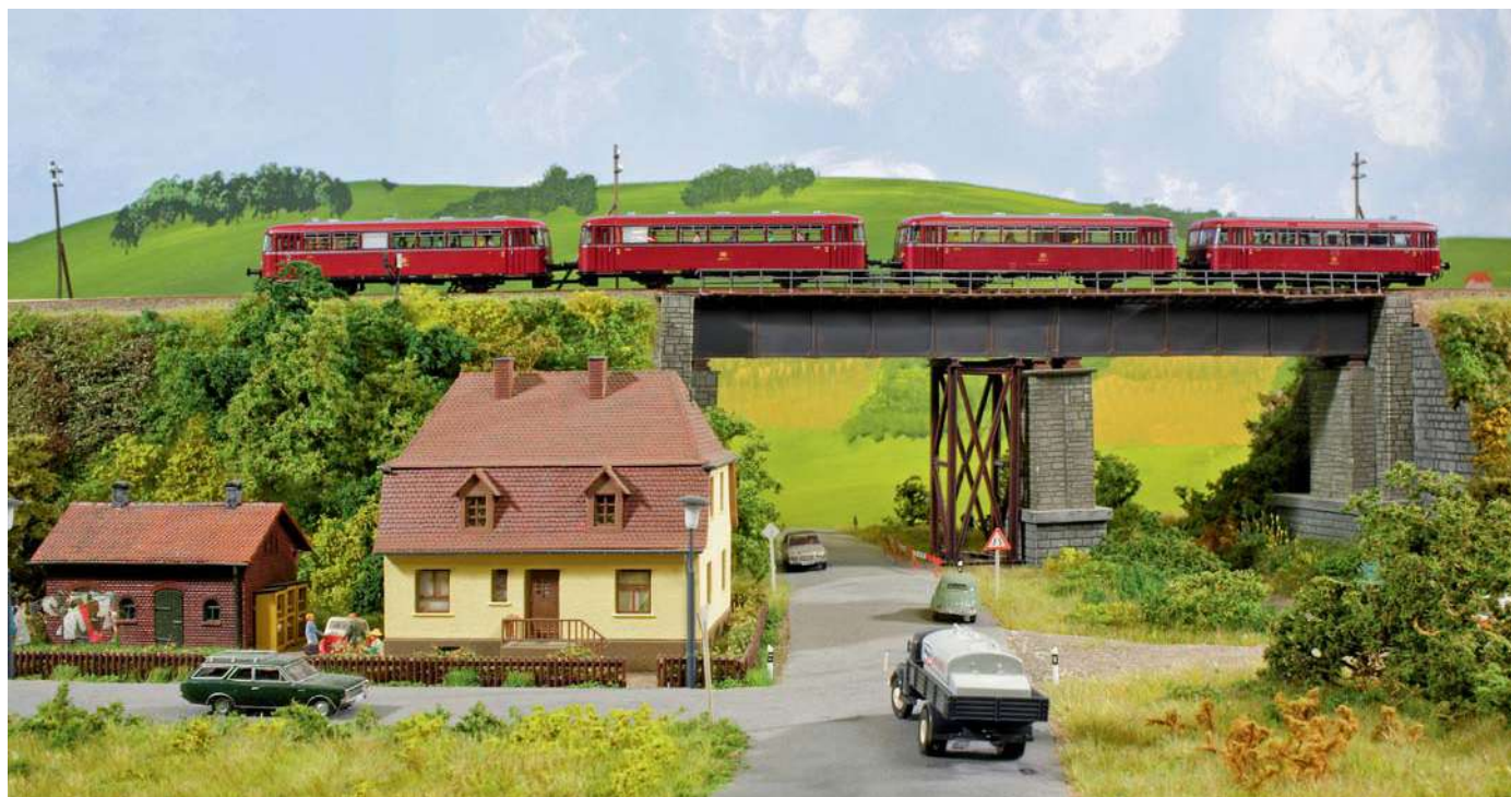
Der Schienenbus überquert eine altersschwache Brücke, die von einem Hilfspfeiler unterstützt wird. Für den Zug heißt das Langsamfahrt.
