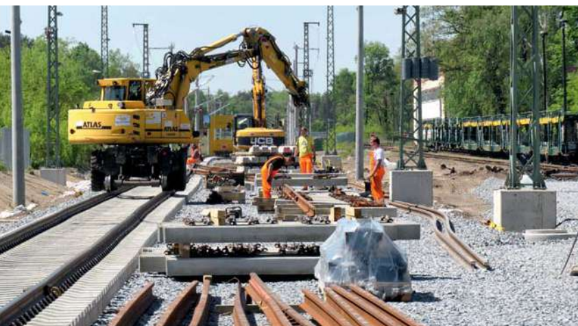
Weit fortgeschritten waren am 5. Mai 2018 die Bauarbeiten in Niesky; rechts der Anschluss zum Güterwagenhersteller Waggonbau Niesky.
