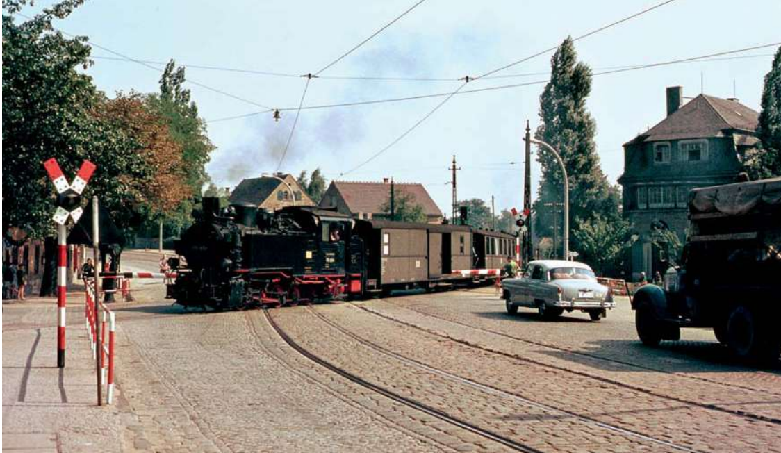
P 1141 kreuzt am „Weißen Ross“ in Radebeul die Meißner Straße und erreicht am 18. August 1966 den Lößnitzgrund. 99 694, ein großteilerneuerter Nachbau der sä. VIK, war praktisch ein Neubau der DR. Bei diesen Loks war der spurkranzlose dritte Radsatz angetrieben.
