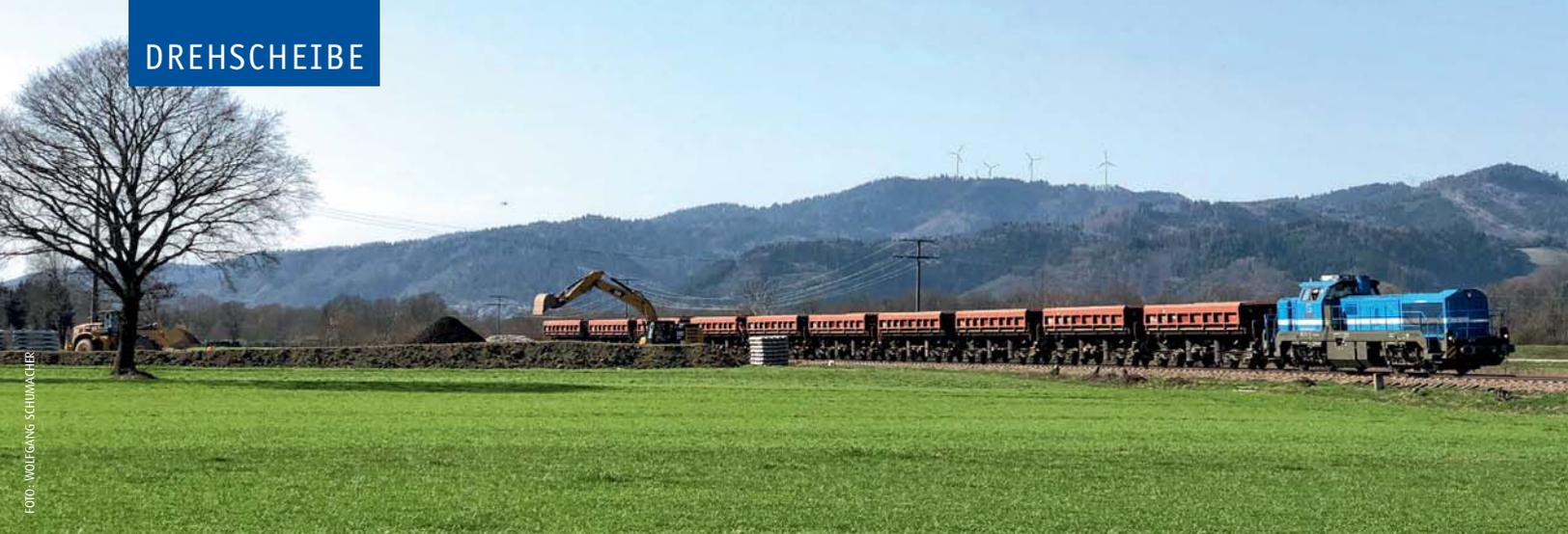
Bei der Untergrundsanierung fällt auch Aushub-Material an, das natürlich in speziellen Waggons per Bahn abtransportiert wird.
