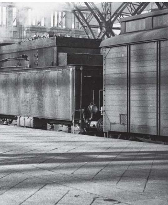
Hbf erreicht. Auf dem Umlauf ist der Hauptluftbehälter der verstärkten Bremsanlage zu erkennen.
