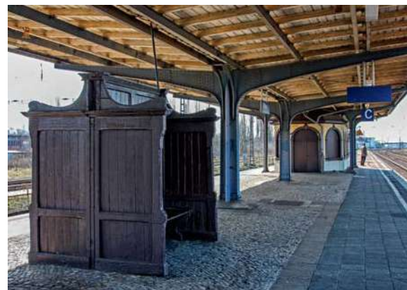
Die historischen Bahnsteige sollen erhalten bleiben und denkmalgerecht saniert werden.
