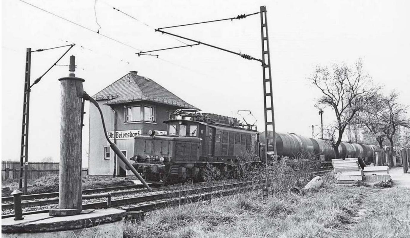
Diese hölzerne Wasserpumpe mit einem Betonschachtring an der Strecke Leipzig – Hof stammte wahrscheinlich aus dem Jahr 1936.
