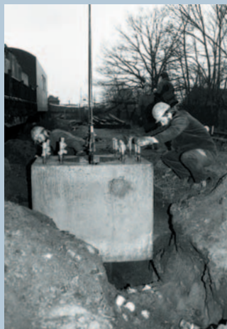
Im Januar 1990 werden in Frankfurt (Oder) Rbf Fundamente gesetzt. Gut zehn Jahre später wird die Oberleitung zurückgebaut.
