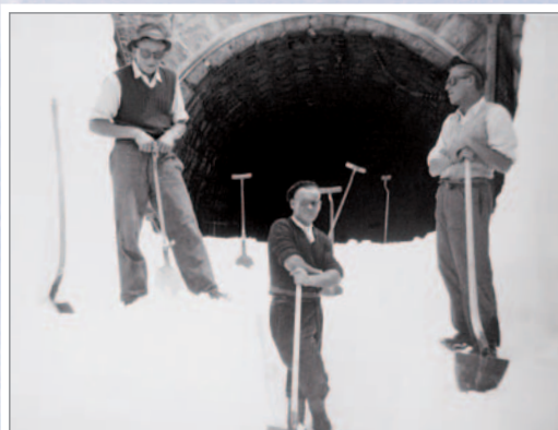
Karl Werlen (Mi.) mit Kollegen vor dem Westportal des Furka-Scheiteltunnels nach der Freilegung.
