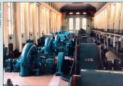
Die Maschinenhalle des Walchensee-Kraftwerks: Links Turbinen, rechts Generatoren.
