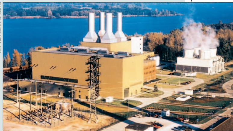
Das Kraftwerk Kirchmöser, unweit von Brandenburg a. d. Havel, dient der zentralen Bahnstromversorgung in den neuen Ländern.
