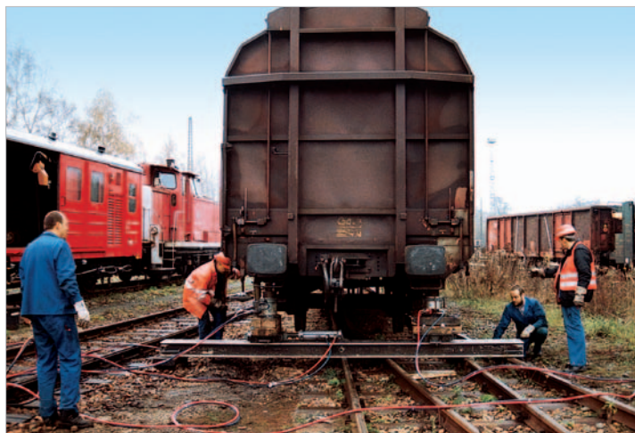
Am 12. November 2004 entgleiste im Gelände des ehemaligen Raw Zwickau ein Schiebewandwagen. Der Einheits-hilfszug kam mit seiner Technik wie den hydraulischen Stempeln (u.) zum Einsatz, rechts die Zuleitungssteuerung.
