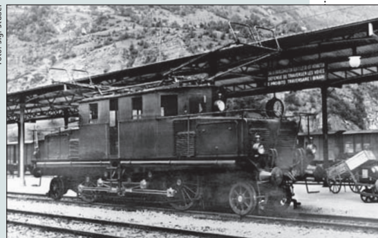
Drehstrom-Lok der Simplon-Bahn, gut erkennbar der geteilte Stromabnehmer.
