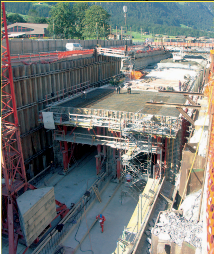
Das Nordportal und ein Teil des Basistunnels in Frutigen entstanden in offener Bauweise.
