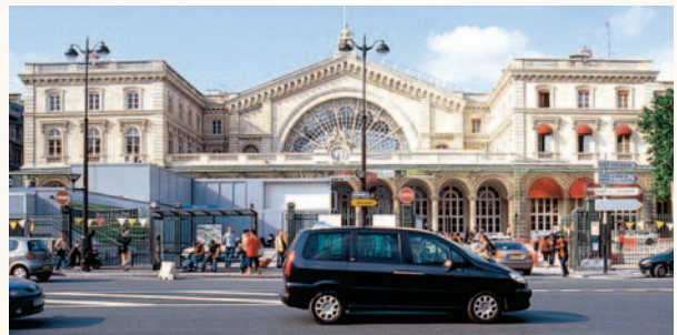
Paris, 10. Juni 2007: Am Hauptportal des 1849 eröffneten Kopfbahnhofs Gare de l'Est wird derzeit noch gebaut.
