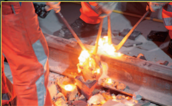
Der „Goldene Nagel“ ist ein besonderes Moment für alle am Gleisbau Beteiligten, vergleichbar dem Tunneldurchstich für die Mineure.
