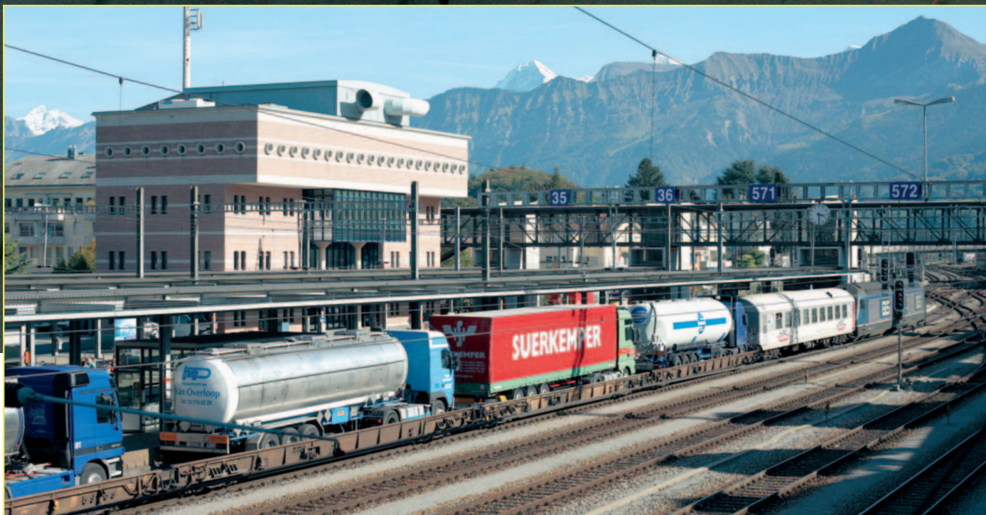
Der gesamte Tunnelverkehr wird von der BLS-Leitstelle in Spiez aus ferngesteuert.
