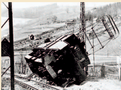
Im April 1958 kippte E19102 wegen falschen Bremsens bei Mittelberg vom Gleis.
