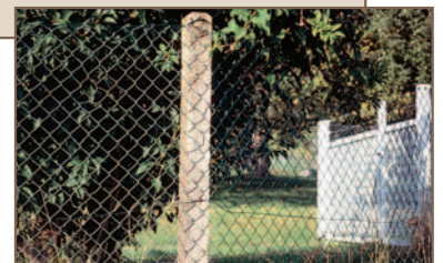
Bei etwas höheren Zäunen wurden früher auch oft Betonpfosten verwendet.
