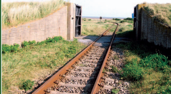
...Inselbahnhof führt die Strecke durch den Deich in den flutgeschützten Ort. Der Durchlass wird bei drohender Sturmflut geschlossen.
