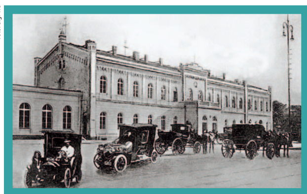
Das Empfangsgebäude von Landsberg entstand 1857 zusammen mit der Strecke von Frankfurt (Oder) über Küstrin nach Kreuz.
