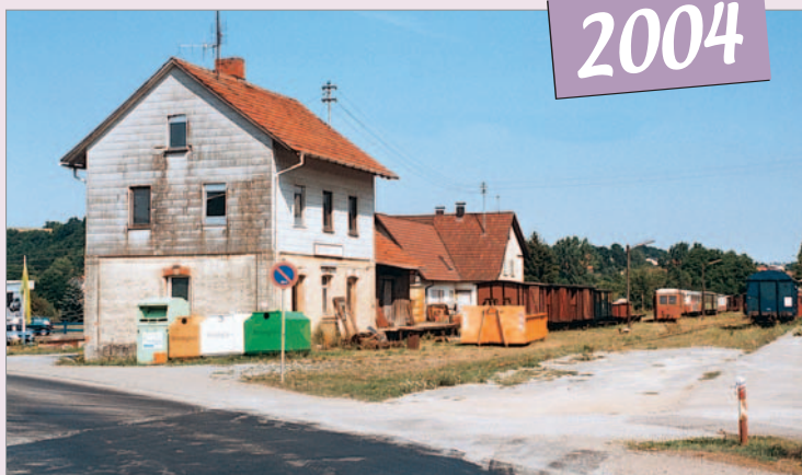
Am 20. Juli 2004 warten in Bieringen zahlreiche Fahrzeuge auf ihre Restaurierung für einen künftigen Museumszugbetrieb.
