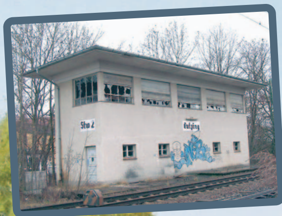
Das Original-Stellwerk in Tutzing zeigt an der Längsfront fünf Fenster.
