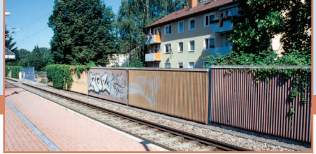
Lärmschutz am Karlsruher Hp Grötzingen-Krappmühlenweg.
