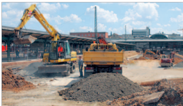
Großbaustelle Kulturbahnhof: Anfang August staubte es gewaltig in Kassels Zentrum.
