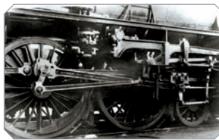
Mit 1905 mm Treibraddurchmesser erreichte die 18.0 120 km/h.
