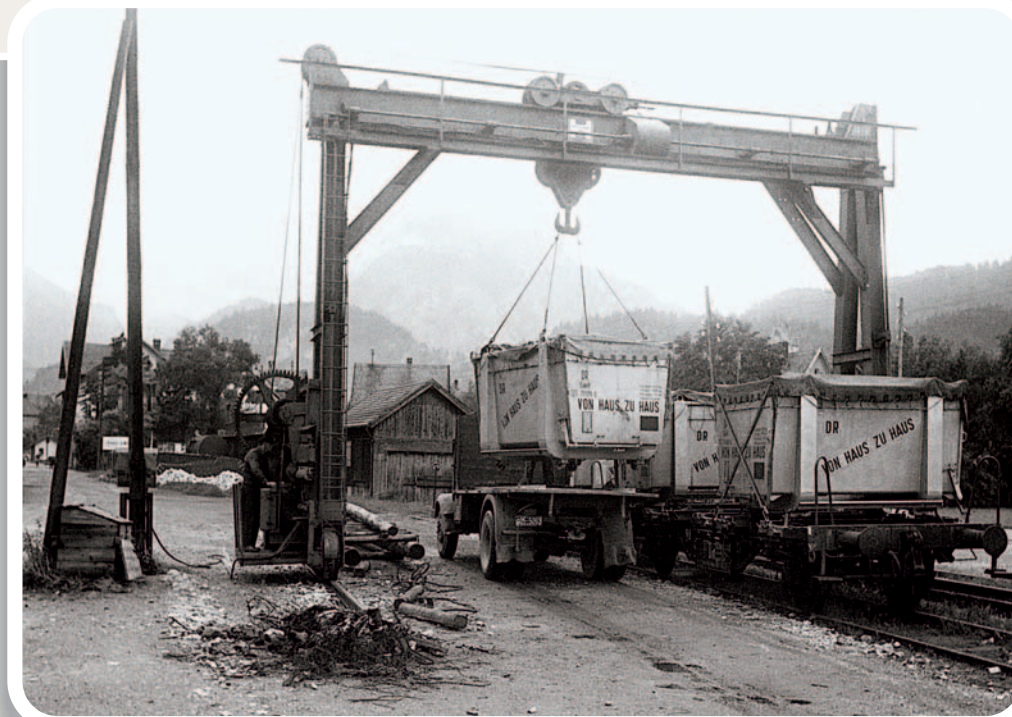
Füssen, 13. Juni 1951: Keineswegs untypisch ist diese Verladeszene mit Kran und konventionellem Lkw.
