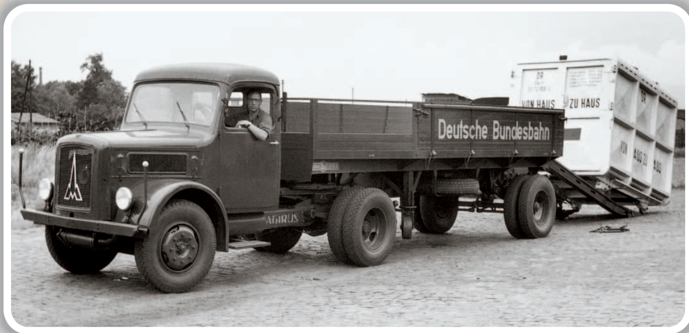
Frühe Bundesbahn mit Magirus: Das Behälter-Sattelfahrzeug, System von Lienen, nimmt einen pa-Behälter vom Planum auf.
