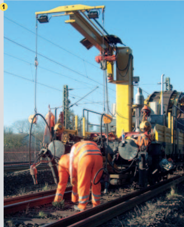
Diese kleine unscheinbare Maschine kann enorme hydraulische Kräfte entwickeln. Sie spreizt die Altschienen aus ihrer ursprünglichen Führung.
