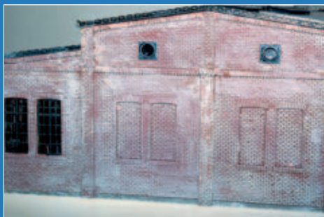
Die Ziegelwände erhalten einen hellgrauen Farbauftrag, der mit einem Tuch verrieben wird.
