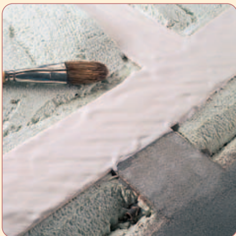
In mehreren Gängen bringt man nun den sämig angerührten Gips auf die Trasse auf.
