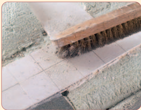
Klopft man mit einer Drahtbürste auf den Weg, entsteht eine leicht raue Oberfläche.
