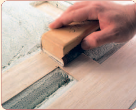
Die Struktur des Sperrholzes glättet man mit einem Schleifstein.
