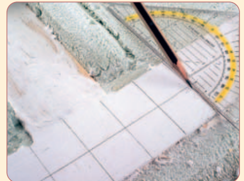
Mit einem spitzen Bleistift zeichnet man die Lage der Fugen an.
