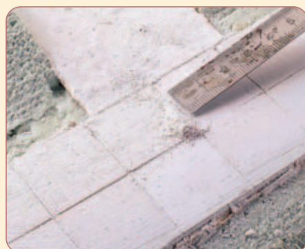
Mit einem Stahllineal nimmt man bei einzelnen Platten Material weg.
