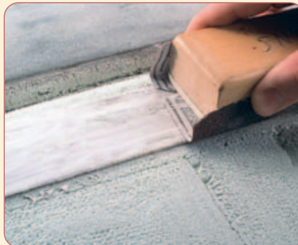
Mit feinem Schleifpapier beseitigt man Unebenheiten der Gipsoberfläche.
