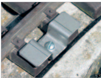
Beidseitig montierte Klemmstücke verhindern Querbewegungen.
