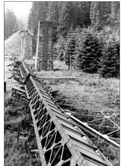
Das war's: Mittels Seilwinden wurden die Brückenträger von den Pfeilern gekippt, 31. Juli 1980. Etliche Tonnen Stahlschrott liegen abholbereit.
