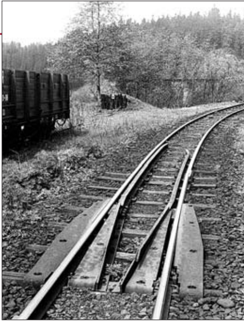
Diese Aufgleisvorrichtung vor dem Viadukt in Schönheide Süd sollte verhindern, dass entgleiste Wagen die Brücke schädigen.
