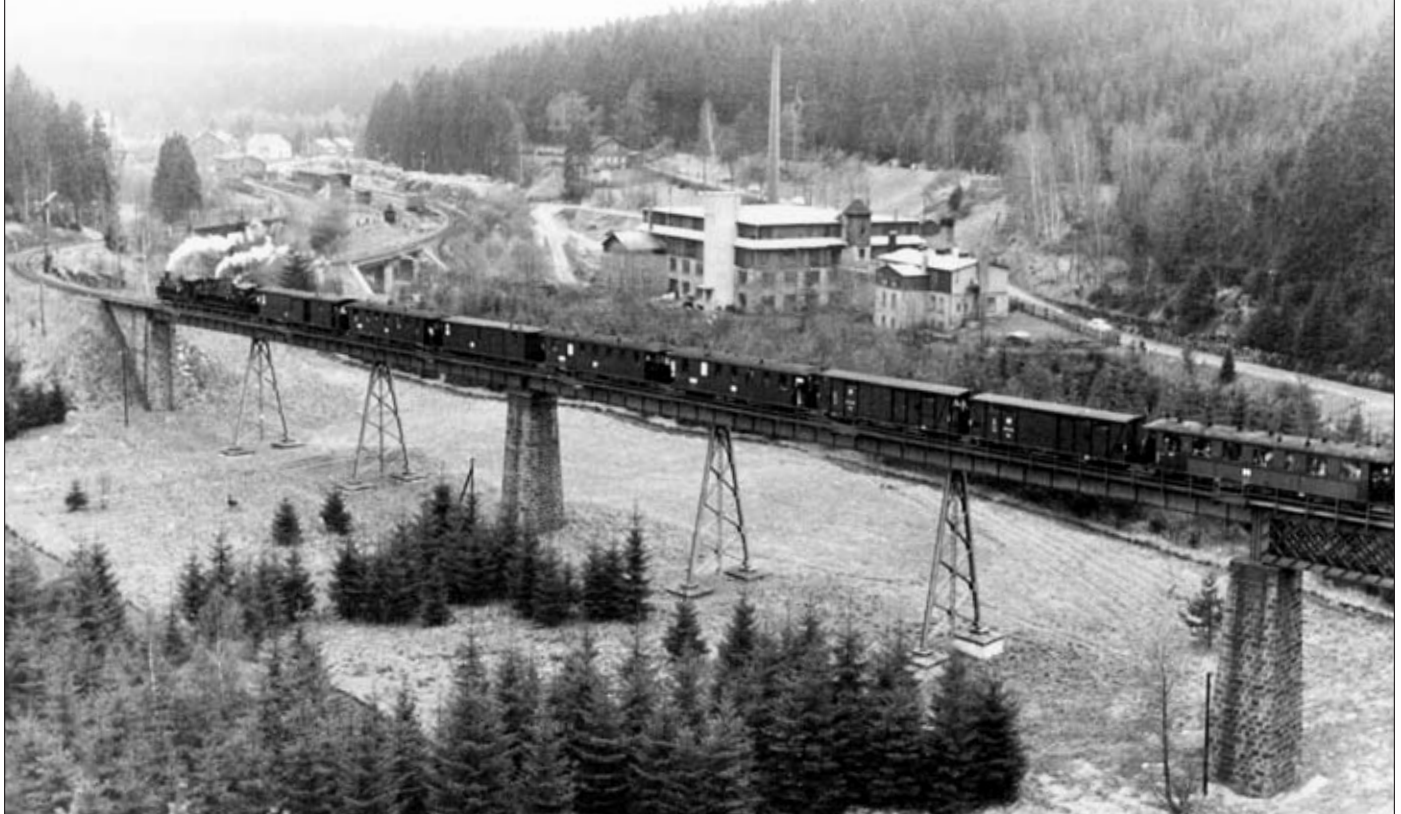
Am 4. Mai 1975 überquerten 99561 und 99590 mit einem Sonderzug aus Richtung Rothenkirchen das Muldetalviadukt.
