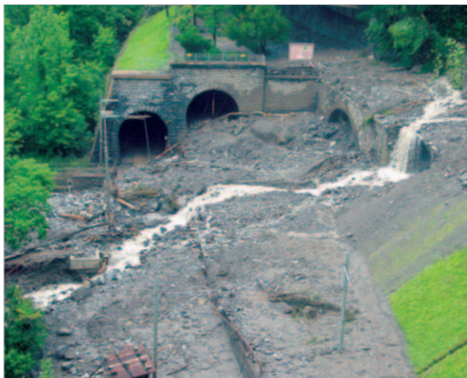
Bei Sisikon am Gotthard-Zulauf beschädigte ein Erdbeutes die Gleisanlagen schwer.
