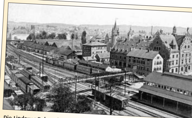
Die Lindauer Bahnanlagen um 1900. Rechts ist die große hölzerne Bahnsteighalle zu erkennen, die zur Eröffnung der Allgäubahn im Jahre 1854 erbaut worden war. 1914 hatte sie dann ausgedient.
