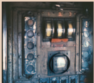
Vor Überlast warnt die sichtlich gealterte Tafel unter den Spannungsmessern.
