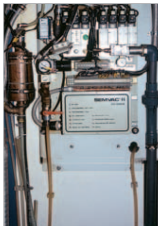
Nur scheinbar Kabelsalat: Die Energieversorgung der Wagen wird von grundauf erneuert.
