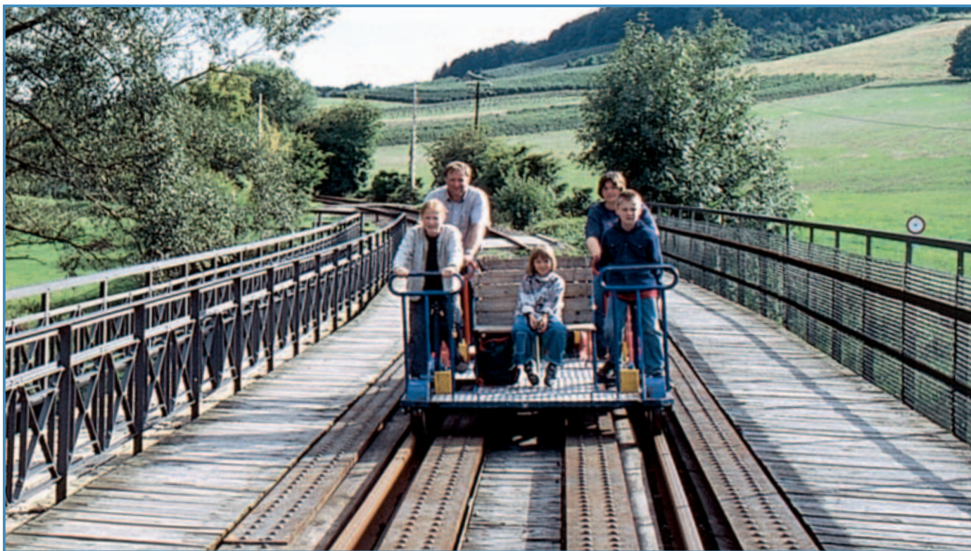
Auf der Glanbrücke vor Odernheim: Marliese und Siegfried Gehringer aus Blaufelden genießen die außergewöhnliche Bahnfahrt mit ihren Kindern und sammeln Eindrücke für die heimische Team-Anlage.
