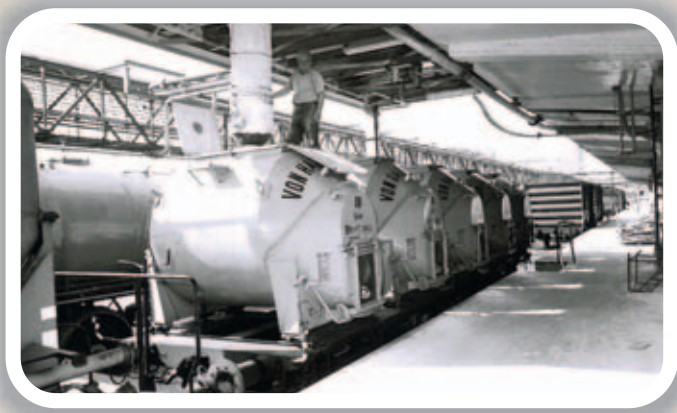
Von oben: Dieser pa-Behälter der Gattung Efvkr wird im Handumdrehen per Fallrohr mit Kunststoff beladen.
