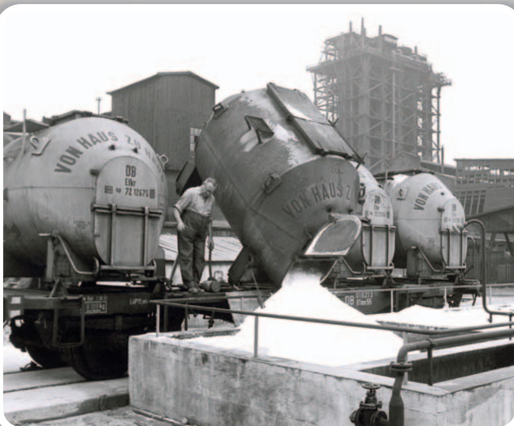
Von der Seite: Mit Hilfe einer Kippvorrichtung wird der Feinschüttgut-Behälter, Gattung Efrk, entladen.
