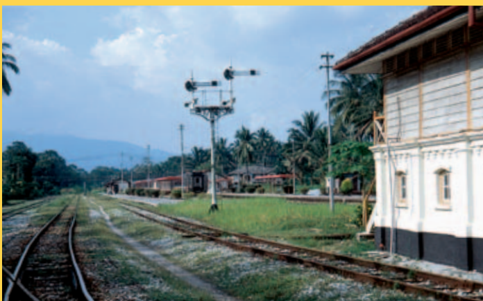
Die Flügelsignale im englischen Stil stammen aus der Kolonialzeit. Sie werden vom Stellwerk Süd des Bahnhofs Tappa aus bedient.
