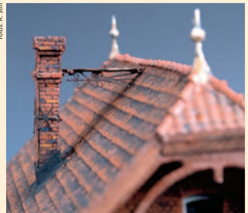
Wunderbar filigran wirkt die Verbindung des Schornsteins mit dem Dach.
