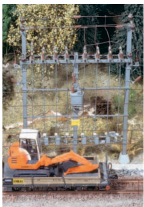
Bergün: Hier steht ein typischer RhB-Schaltposten.
