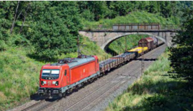
Der Bogen einer Feldwegüberführung bei Jossa ist sehr nahe am Lichtraumprofil zur Oberleitung
