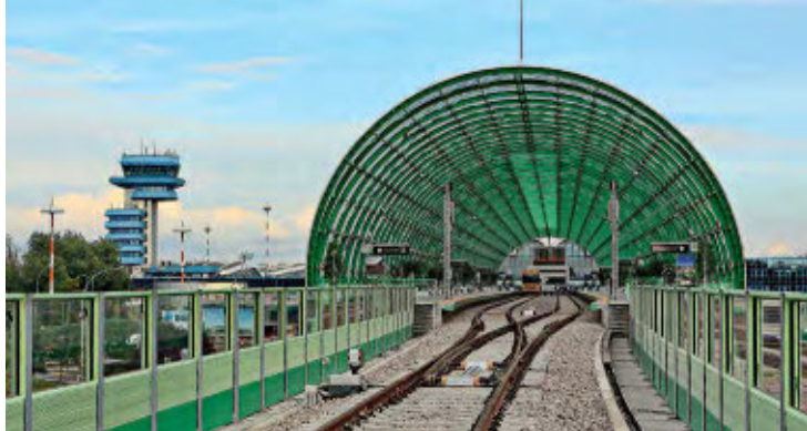
Ab Dezember in Betrieb: Flughafenbahnhof in Bukarest Mircea Dorobantu
