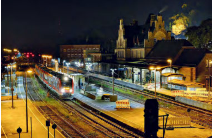
Die Umgestaltung des Bahnhofs Gerolstein läuft im Oktober 2020 auf Hochtouren, die Bahnsteigdächer sind schon demontiert K. Kampelmann
