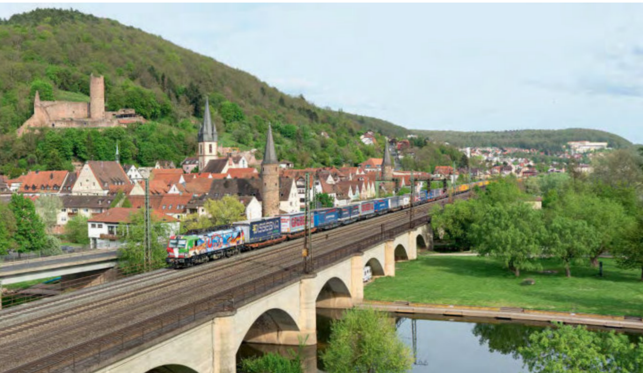
Bevor die Strecke in Gemünden in das Sinntal abbiegt verläuft sie einige Meter parallel zur Linie nach Aschaffenburg. Am 24. April 2019 überquert 193 640 mit einem KV-Zug Richtung Flieden die Saale P. Bötsch
