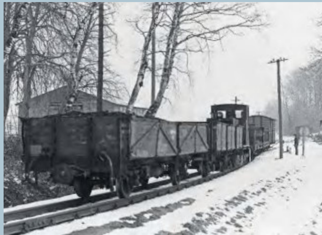
Gleisbauarbeiten in Garftitz, im Einsatz dabei ist die Diesellok 100 901
