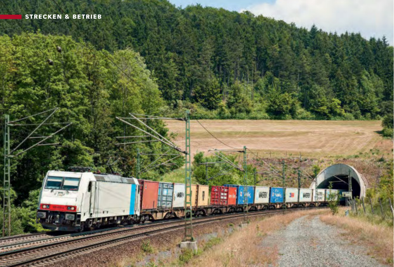
Die Tunnel zwischen Gemünden und Flieden werden saniert. Bereits 2008 wurde der Ramholz-Tunnel durch einen Neubau ersetzt, den 185 638 am 15. Juni 2012 mit einem VIAS-DGS verlässt Rainer Nenninger (2)
