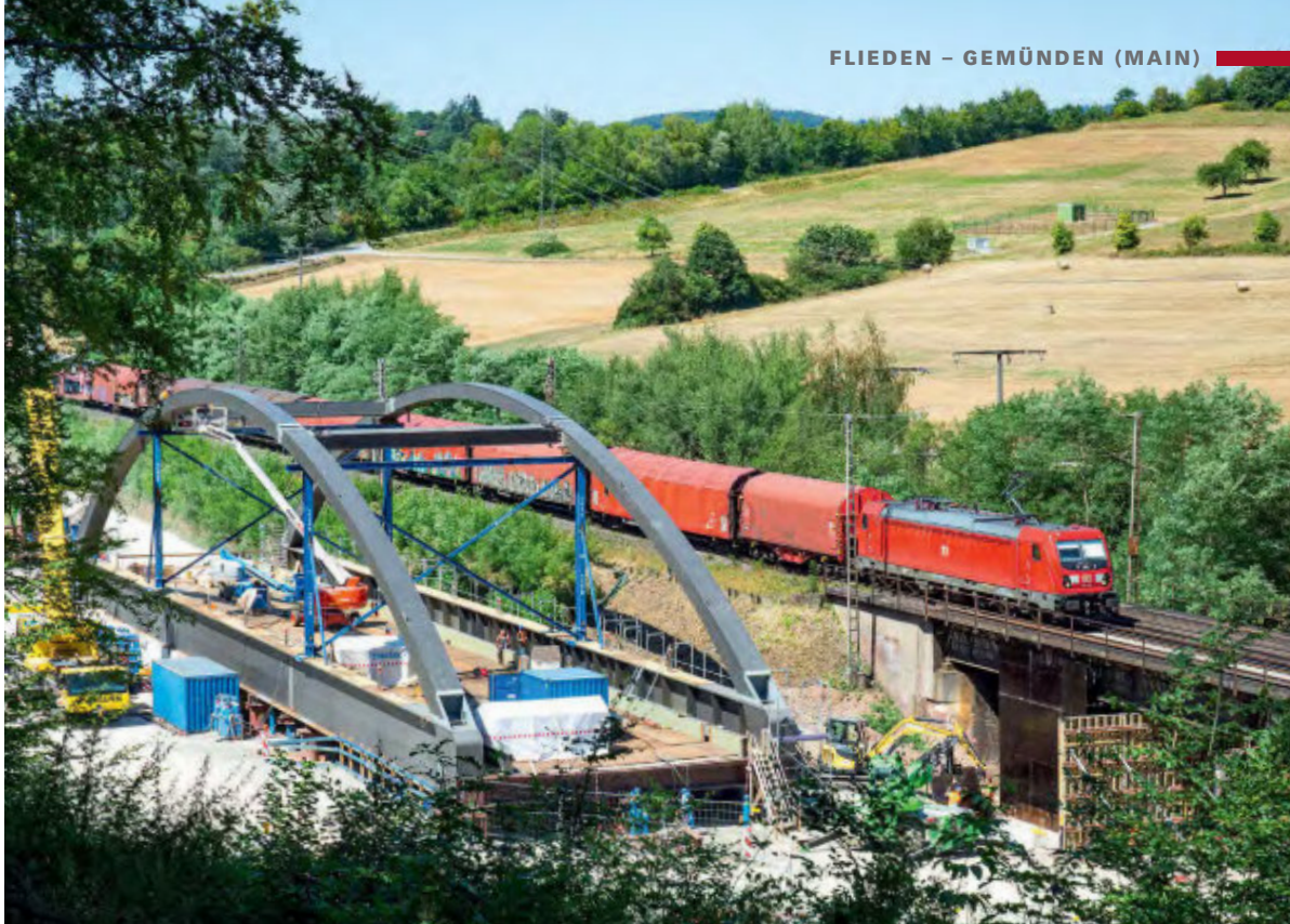
Im November 2020 werden südlich von Rieneck zwei Brücken erneuert. Am 6. August 2020 passiert die Mannheimer 187 155 mit EZ 51199 Seelze Rbf – Nürnberg Rbf die Baustelle (km 52,4)
