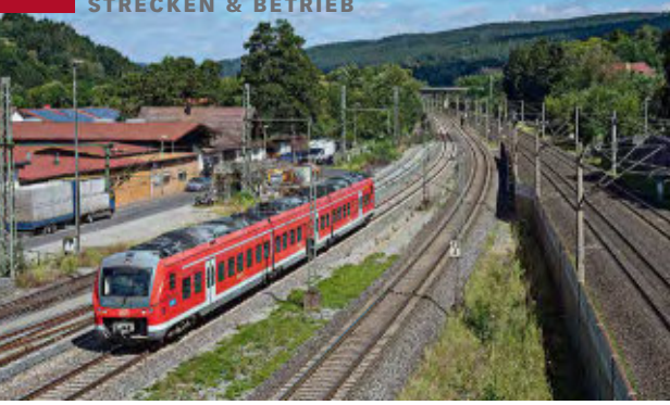
440 320/820 als RB 58035 am 29. Juli 2020 bei Burgsinn, rechts die Schnellfahrstrecke
