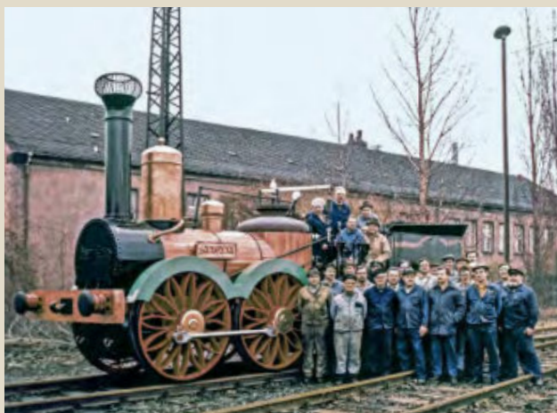
Die am Bau beteiligten Mitarbeiter voller Stolz vor der SAXONIA, das Raw war Finalproduzent der Lok. Hinten die Betriebsberufsschule Rolf Dieter Just
