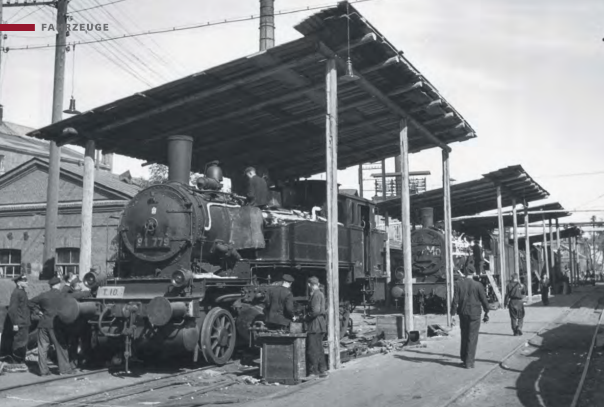
Im EAW Gomel rüsten Arbeiter unter Behelfsbauten eine preußische T 9 3 sowie weitere Länderbahnloks mit provisorischen Frostschutzeinrichtungen für den bevorstehenden Wintereinsatz aus Slg. Andreas Knipping
