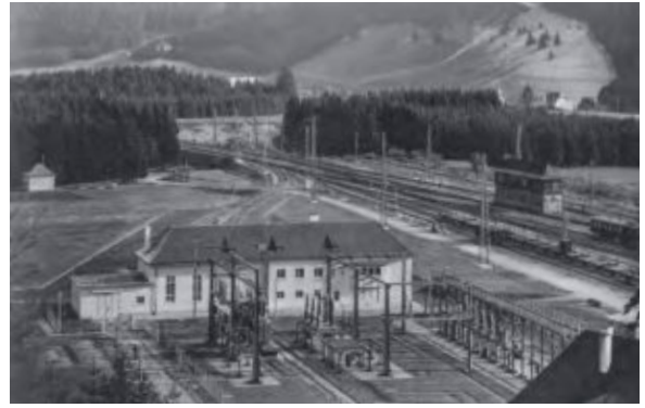
Neben dem Bahnhof Titisee errichtete die Reichsbahn 1935/36 ein Umspannwerk zur Stromversorgung von Höllental- und Dreiseenbahn Slg. O. Strüber
