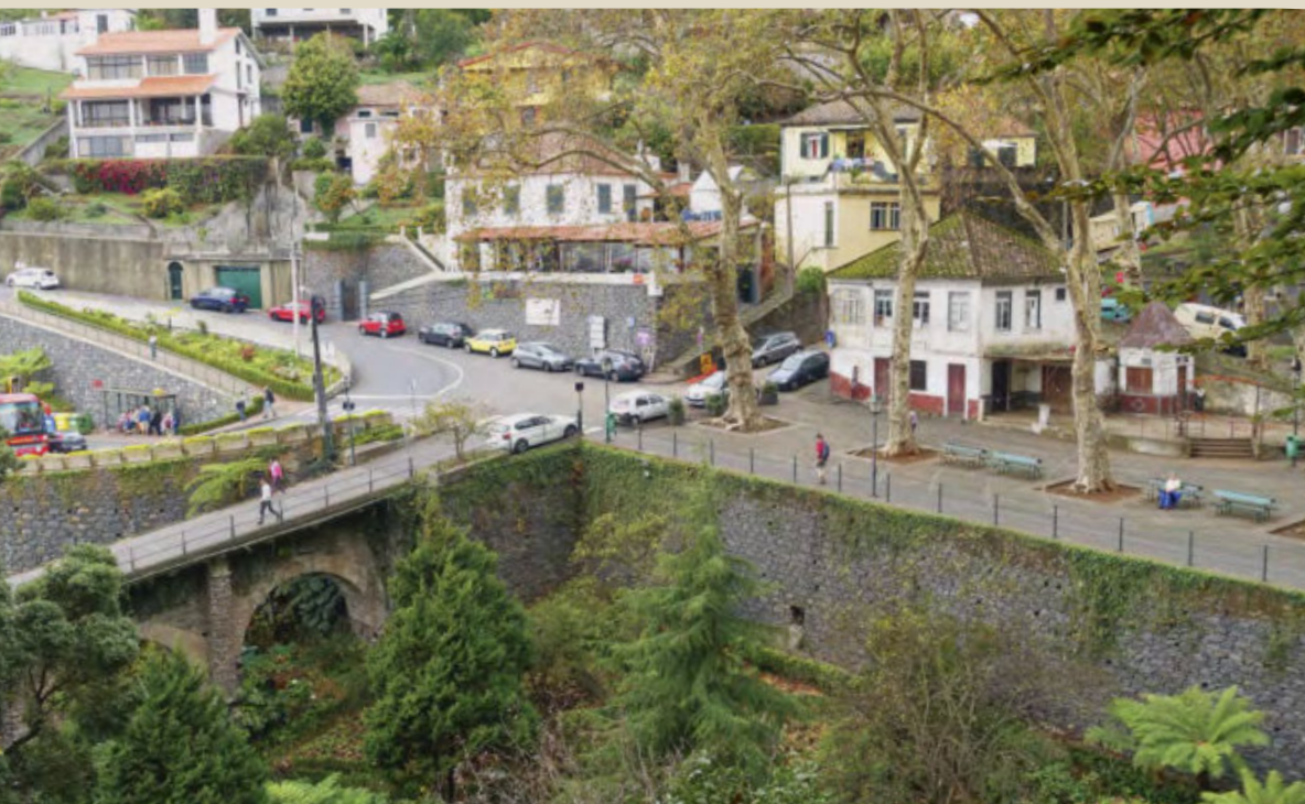
Blick auf das Stationsgebäude des einstigen Bahnhofs Monte und das Viadukt
