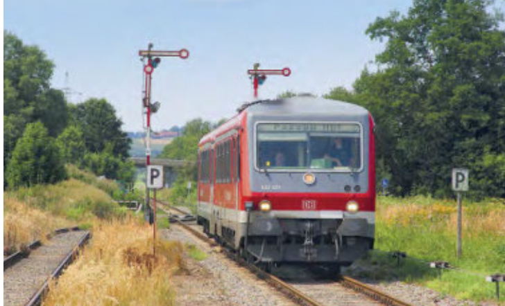
Unter anderem im Bereich Karpfham (Foto) wurden auf der Strecke Mühldorf – Passau Langsamfahrstellen eingerichtet
