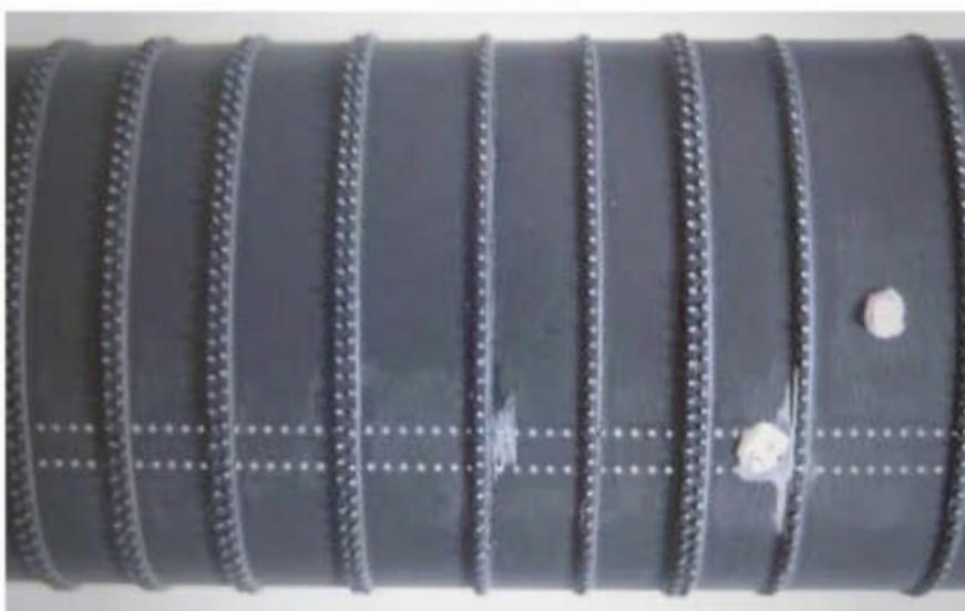
**24** Prévoyez le raccord entre les deux parties conservées au raz d'une bande rivetée : il sera ainsi totalement invisible après peinture. Découpez les parties conservées, en laissant un peu de marge en longueur. Puis ajustez-les à la lime progressivement, en les présentant fréquemment à blanc.
