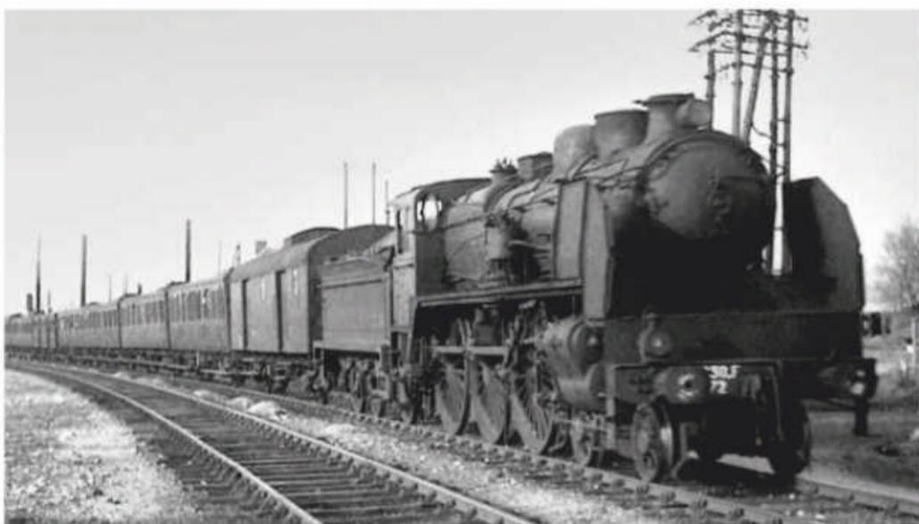
Omnibus pour Le Mans pris au passage à niveau de la rue Raspail à Tours (37) en avril 1952. 230 F avec voitures à portières latérales type P.O. Noter, au milieu de la rame, une voiture déjà métallisée et le fourgon type Midi derrière la machine.
