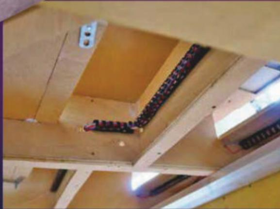
Pour la propreté du câblage, j'ai recouru à ma technique habituelle, on ne peut plus économique et on ne peut plus pratique : des anneaux de reliure en plastique, collés sur les entretoises avec un pistolet à colle. On y installe des fils aussi commodément qu'on en ôte, puisque les anneaux restent ouverts, et les nappes de fils sont ainsi remarquablement bien endiguées.
