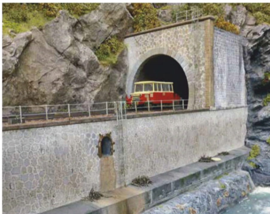
7 Une paroi fermant le côté du tunnel est peu commune. Le long mur de soutènement est percé d'une sortie des eaux de ruissellement. Une échelle à crinoline permet d'accéder au renforcement de la base de ce mur.
