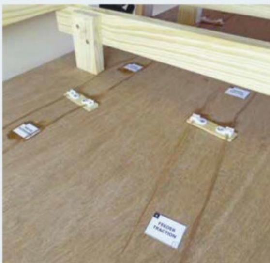
Des agrafes Viessmann réf. 6846 servent à fixer les fils de 2,5 mm sous la plateforme. Des étiquettes permettent d'identifier le type de feeder.
