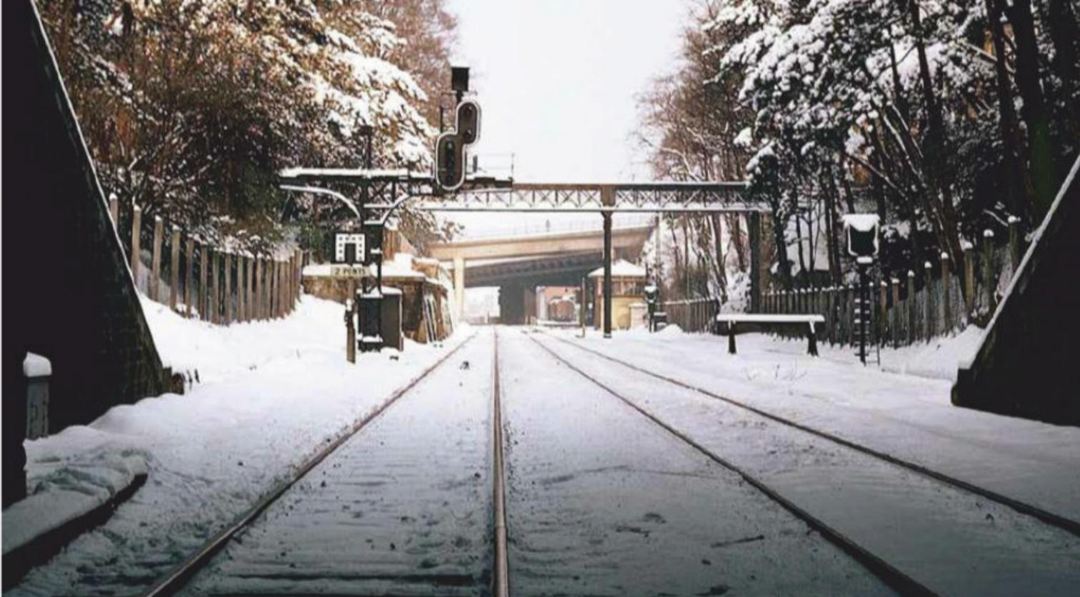
Vue du tunnel des Buttes-Chaumont vers le nord. Au fond, le pont de la rue de Crimée. Le signal porte un rappel de ralentissement lié à l'aiguille d'accès aux embranchements de la Villette.
