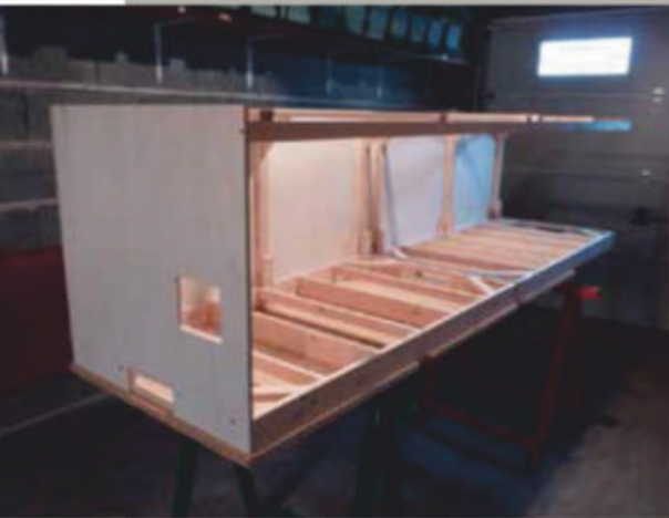
Construction des quatre caissons en contreplaqué.
