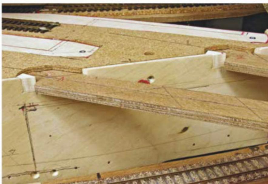
**5** Les tabliers des ponts sont constitués par des languettes de contreplaqué de 8 mm, découpées dans le même panneau que les plateformes adjacentes. À leurs extrémités, les deux languettes sont encastrées dans les échancrures montrées à la figure précédente et viennent bien à fleur des plateformes contiguës. Évidemment, je me suis préalablement assuré de leur parfaite planéité.
