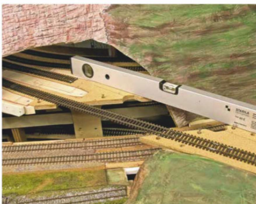
**2** Après établissement d'une assise solide bien horizontale, la plateforme des voies supérieures a été sectionnée à l'emplacement des futurs ponts.
