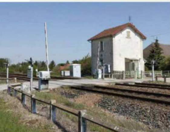
À Savières, les parements sont en pierres.
