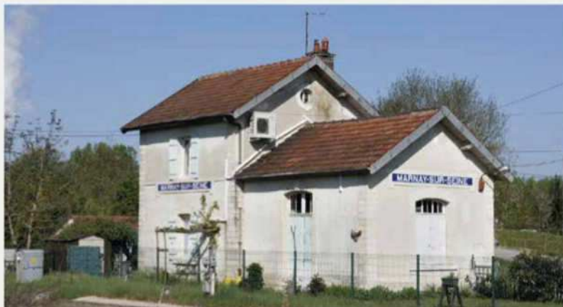
La halte de Marnay-sur-Seine est aujourd'hui fermée mais le bâtiment existe toujours.
